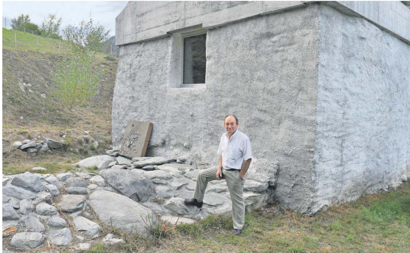
Zufrieden. Stiftungsratspräsident Heli Wyder vor der renovierten Suste in Gamsen.
