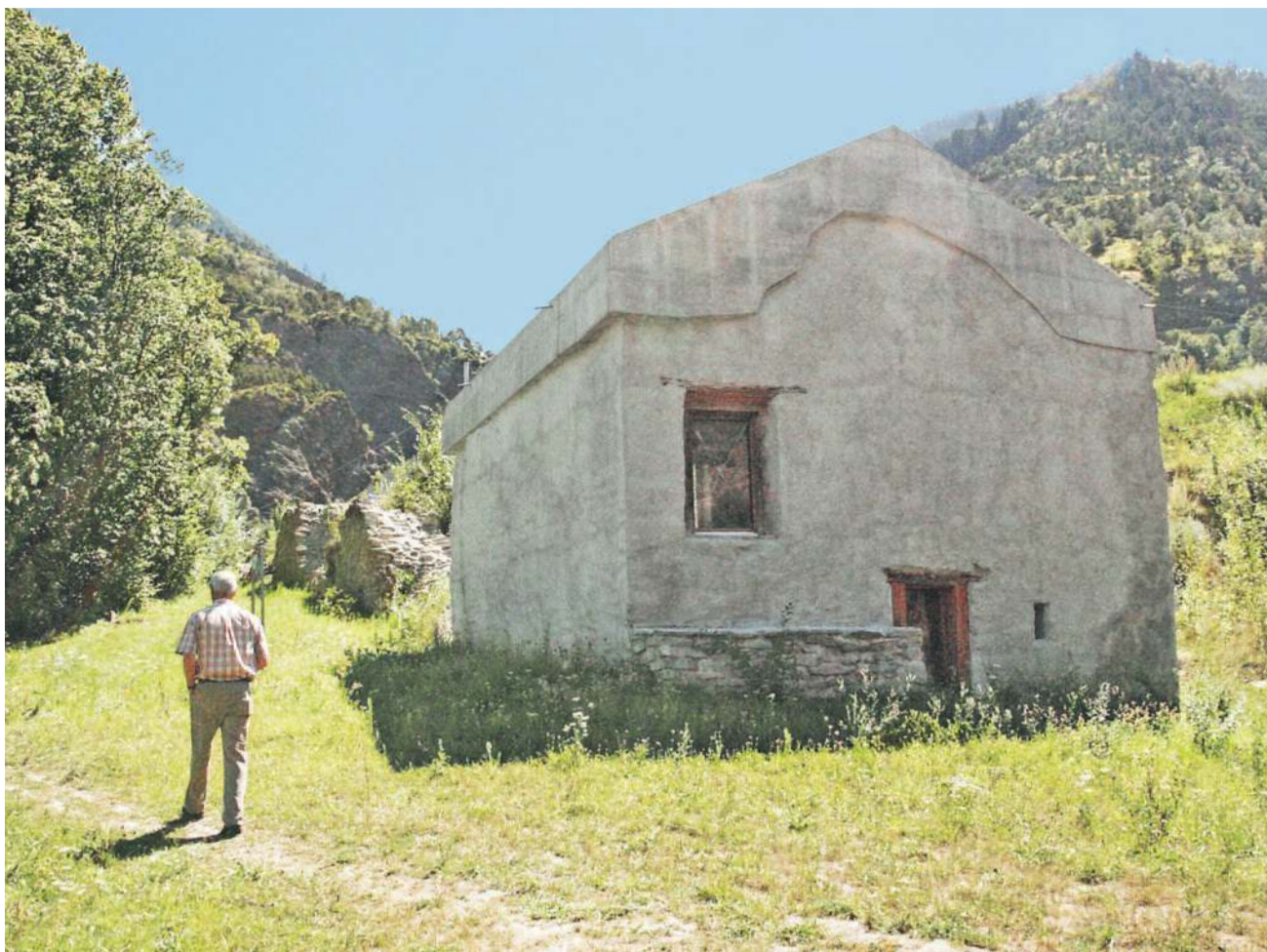
Der sanierte und etwas gewöhnungsbedürftige Bau an der Gamsamauer, am Weg zum Rohrberg. Ursprünglich soll das Gebäude, das letztlich als Stallscheune diente, als Suste und Kontrollpunkt seinen Zweck erfüllt haben. Als Info- und Ausstellungsraum kommt der alten und neu erstandenen Suste eine neue Aufgabe zu.
