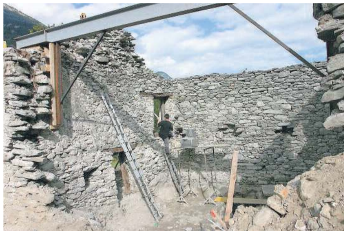
Das Gebäude an der Landmauer während der Sanierung.
