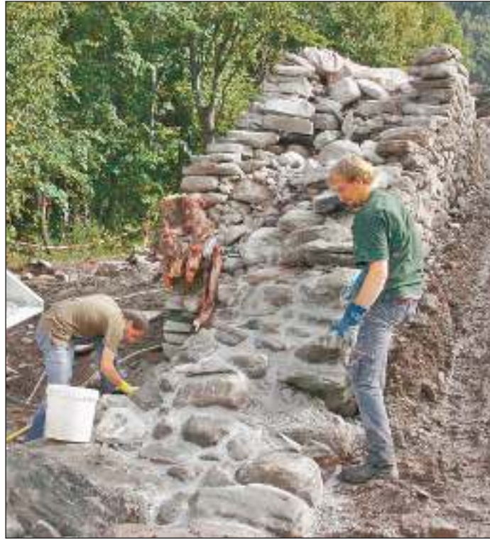
Die Restaurierung der Mauer ist grösstenteils abgeschlossen und erforderte eine Investition von ca. 900 000 Franken. Die Landmauer besteht aus zwei Schalen, der Kern besteht aus Füllmaterial.
