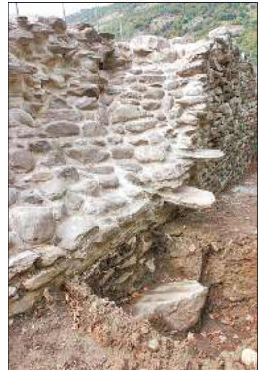
Die Mauer reichte ursprünglich um 1 m tiefer ins Erdreich. Hier führten sechs Treppensteine auf die Zinne der ca. 7 m hohen Wehranlage.
