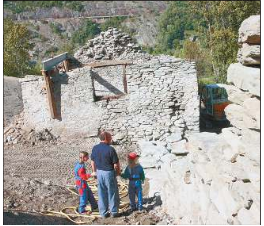
Die von Überwucherungen und Ablagerungen freigelegte Stallscheune, neu Suste genannt. Die Aussenwände sind durch Klammern gesichert. Im Bild erkennbar: Landmauer durchzog das Gebäude, das gegenwärtig archäologisch untersucht wird.
