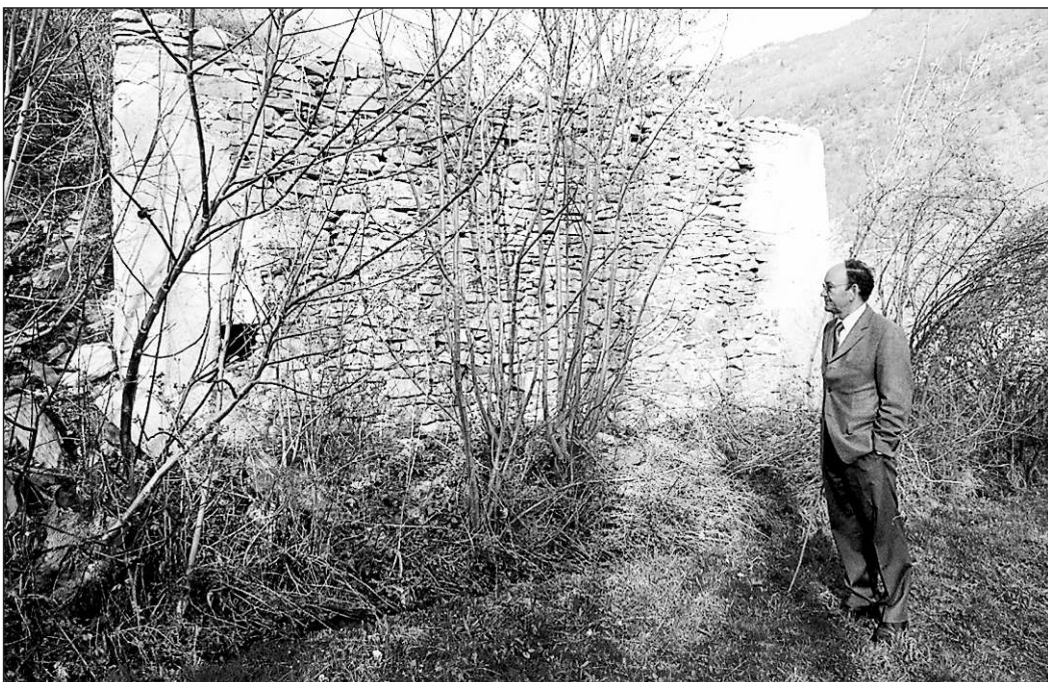
Die alte Stallscheune an der Landmuer. Laut einem Konzept der Stadtgemeinde Brig-Glis soll der landwirtschaftliche Nutzbau im Zusammenhang mit dem Bau der Nationalstrasse restauriert und dem neu zu schaffenden Naherholungsgebiet zur Nutzung zugeordnet werden.
