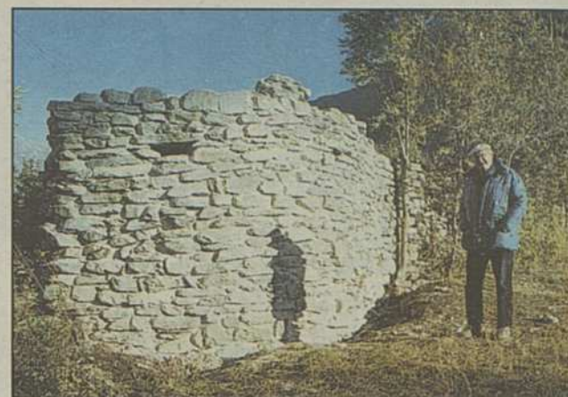
Detail aus der sanierten Landmauer.
