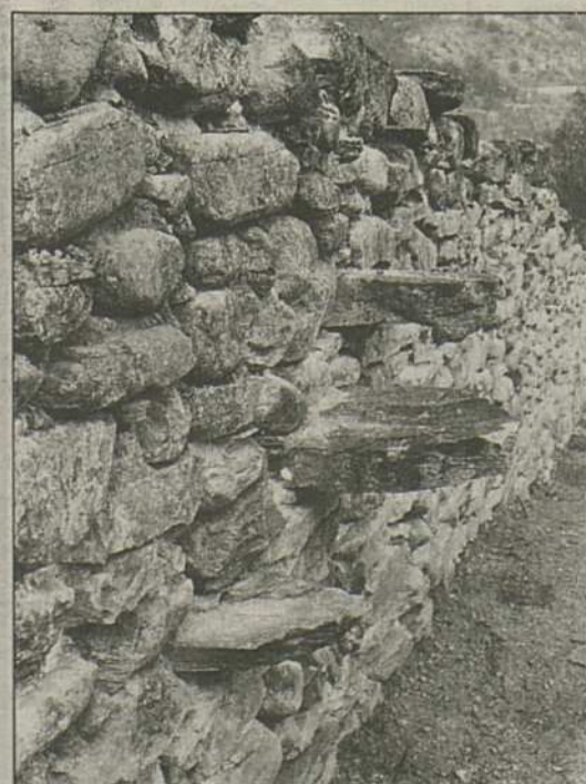
Ostseitig standen den Verteidigern die vorkragenden Steine als Treppen zur Verfügung.
