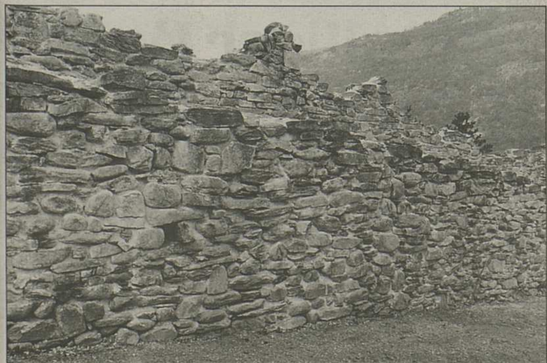
Das restaurierte Teilstück im südlichen Bereich. Dass die Landmauer gegen Westen gerichtet war, lässt sich aus dem Wehrgang hinter der einst zinnenbekrönten Brustwehr erkennen.
