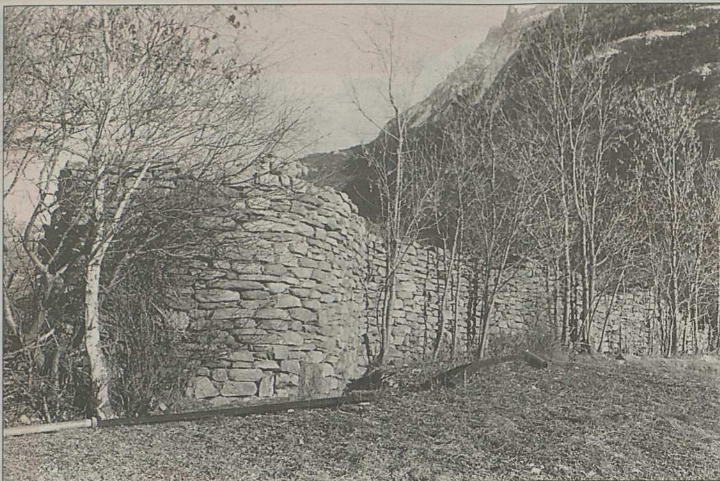
Blick auf den besterhaltenen Teil der Landmauer (Letzine) bei Gamsen, die sich einstmalig von den Felsen der Gamschlucht bis zum Rotten hinzog. Das Bauwerk mit Zinnen, Wehrgang und Basteien entstand im 14. Jahrhundert und ersetzte als Nachfolgebau einen bereits bestehenden schützenden Wall. Die zu gründende «Stiftung Landmauer Gamsen» übernimmt nun das historisch interessante Bauwerk als Eigentum und bemüht sich um den Erhalt. Mit der Übernahme der Mauer erwirbt die Stiftung auch Boden entlang der Mauer. Eine von Dr. Lukas Högl, Konsulent der Eidgenössischen Kommission für Denkmalpflege, erarbeitete Kostenschätzung rechnet mit einer Investition von 1 200 000 Franken.
