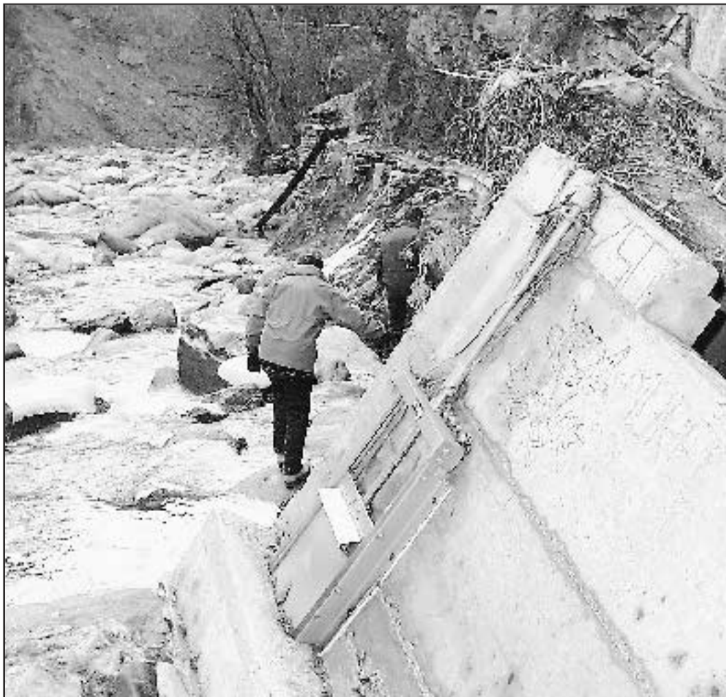
Zerstörte Wasserfassung für die «Uneri Brigeri» im Grindji.
