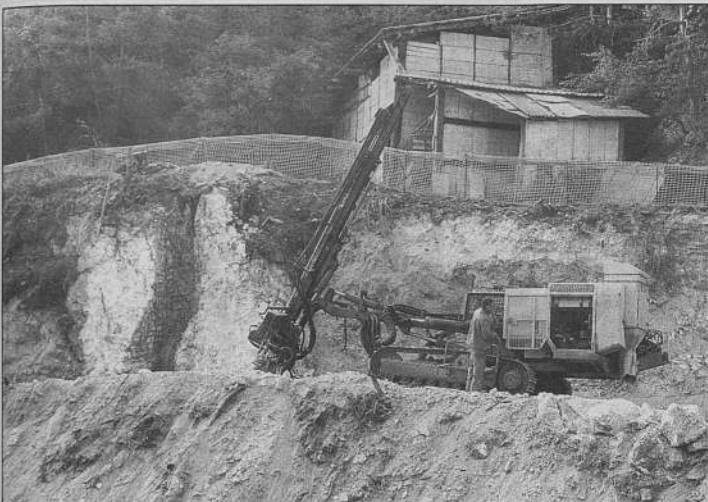
Mit schwerem Geschütz und vernichtender Kraft greifen die Maschinen in das gipshaltige Gestein in der «Kriden Fluh» und eben der künftigen A 9 das Trasse. Die ältesten Spuren der Gipsausbeutung weisen die Archäologen in die römische Epoche.
