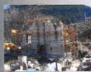
BEROST + BETONWAND WESTSEITE
