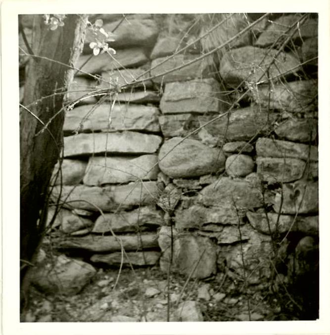
Die alte Mauer, Jfangmauer genannt. Nahtstelle f in der Mitte der Mauer. 14. Jahrhundert, da gleiche Bauart, wie die Landmauer von 1350 - 1355. Deutlich erkennt man die Schichtung der leicht gebogenen Steine, mit der Krümmung nach oben. Sektor VII
