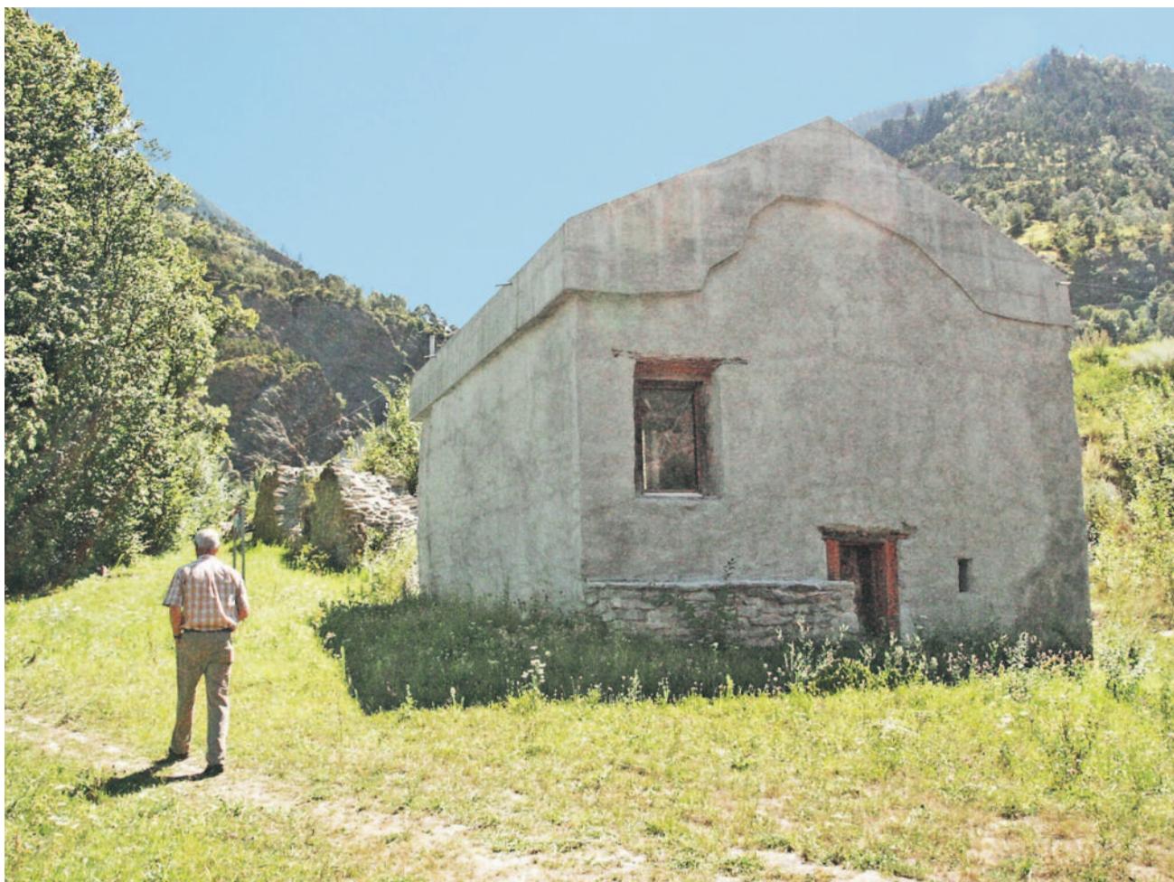
Der sanierte und etwas gewöhnungsbedürftige Bau an der Gamsamauer, am Weg zum Rohrberg. Ursprünglich soll das Gebäude, das letztlich als Stallscheune diente, als Suste und Kontrollpunkt seinen Zweck erfüllt haben. Als Info- und Ausstellungsraum kommt der alten und neu erstandenen Suste eine neue Aufgabe zu.
