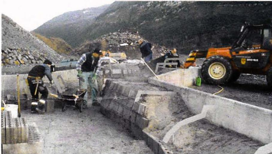
*Abbildung 3: Modellierung der Felspartien mit Hilfe von PVC Profilen in bestehende Betonschale*
