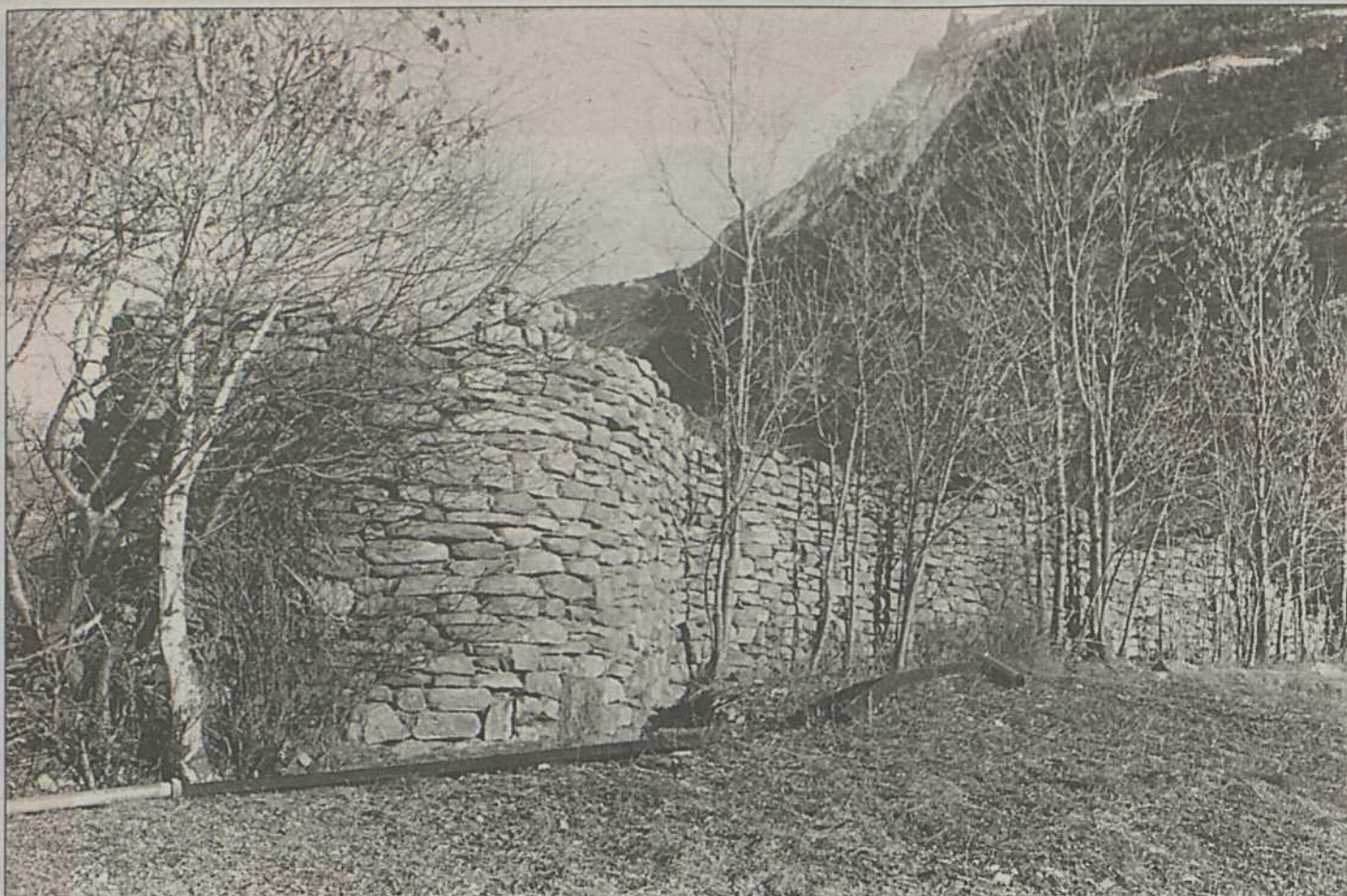
Blick auf den besterhaltenen Teil der Landmauer (Letzine) bei Gamsen, die sich einstmal von den Felsen der Gamschlucht bis zum Rotten hinzog. Das Bauwerk mit Zinnen, Wehrgang und Basteien entstand im 14. Jahrhundert und ersetzte als Nachfolgebau einen bereits bestehenden schützenden Wall. Die zu gründende «Stiftung Landmauer Gamsen» übernimmt nun das historisch interessante Bauwerk als Eigentum und bemüht sich um den Erhalt. Mit der Übernahme der Mauer erwirbt die Stiftung auch Boden entlang der Mauer. Eine von Dr. Lukas Högl, Konsulent der Eidgenössischen Kommission für Denkmalpflege, erarbeitete Kostenschätzung rechnet mit einer Investition von 1 200 000 Franken.
