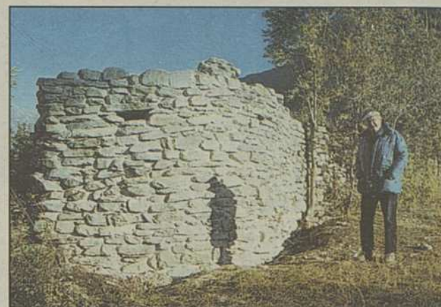
Detail aus der sanierten Landmauer.
