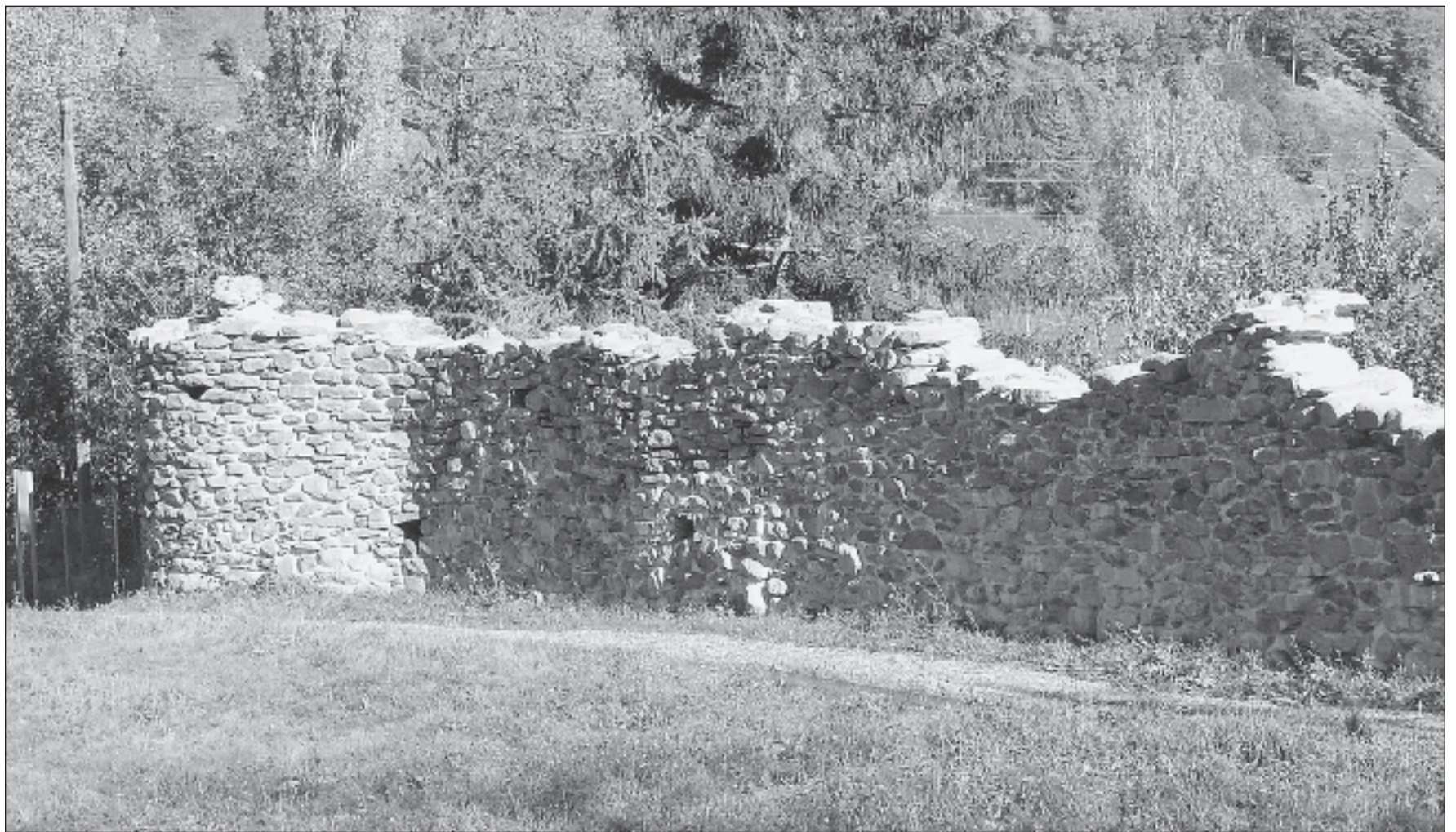
Ein besonders gut erhaltener Abschnitt der Landmauer von Gamsen nach der Restauration. Deutlich erkennbar noch ein Teil eines Wehrturmes. Auf eine Rekonstruktion verzichtet worden, es wurde erhalten, was noch bestand.
