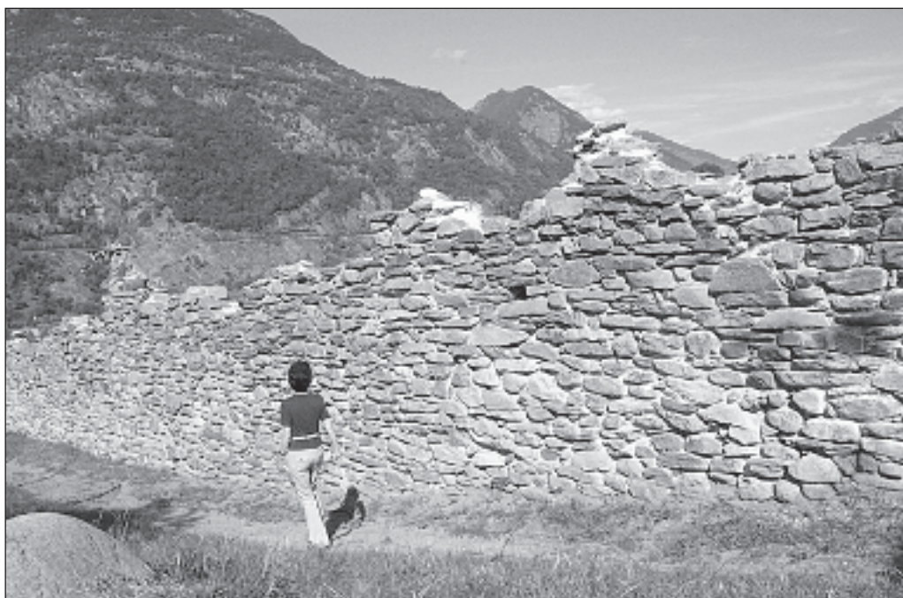
Bei der Landmauer von Gamsen handelt es sich um eine Talsperre, die in ihren besten Zeiten fast 2 Kilometer lang und 6 Meter hoch war.
