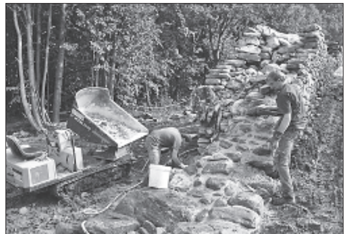
In den Erhalt der mittelalterlichen Gamsamauer wurde von der Stiftung bis anhin 1 Million Franken investiert.
