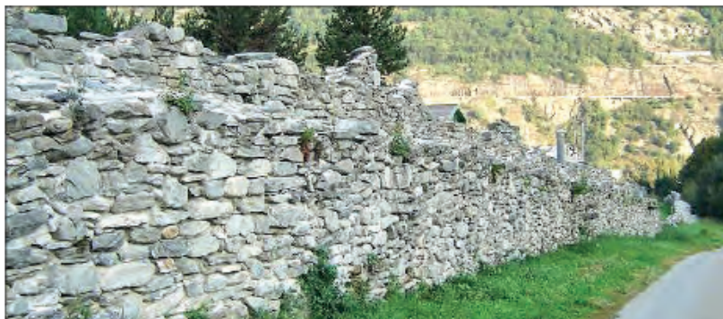
Die Landmauer in Gamsen und die dazugehörige Siedlung wurden während der vergangenen 11 Jahre freigelegt und untersucht.
